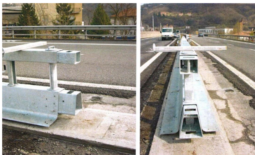
Foto 3 – detail spoje pro rychlé otevření
