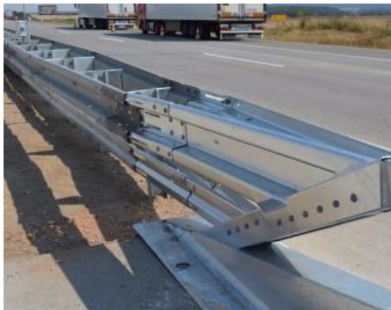
Foto 4 – možnosti napojení na ocelová svodidla Arcelor Mittal
